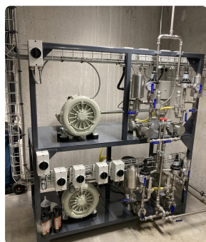
Impianto di Bulle, Svizzera: skid di dosaggio, lance di iniezione sulla caldaia, pannello operatore
